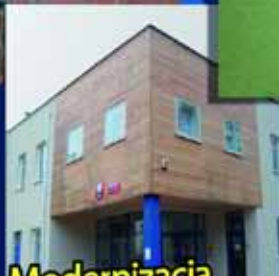
Modernizacja Żłobka Miejskiego
