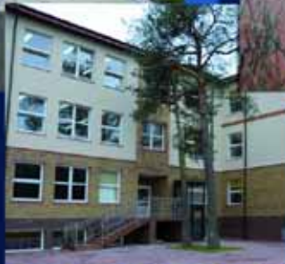
Rozbudowa SP nr 2
